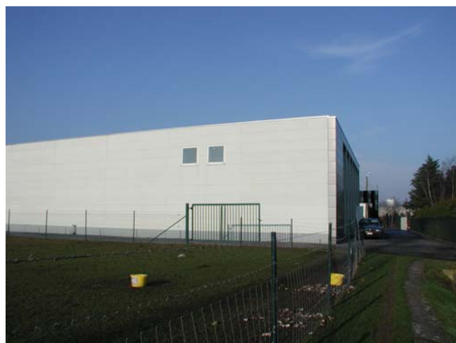
Zicht op achterzijde bestaande loods
